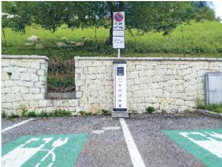
A Luserna Dolomiti Energia ha installato due colonne per ricarica mezzi elettrici
