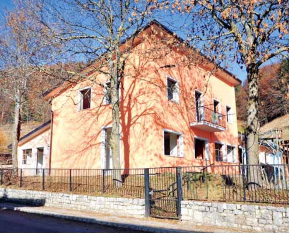
I lavori per la realizzazione del Centro Multiservizi di via Costalta Näüing botèng von Pön Mehrzweckeinrichtung in der Costaltastraße
