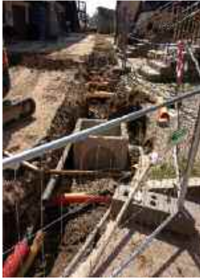
L'intervento sulla rete idrica comunale ha preso avvio dal mese di luglio 2014
