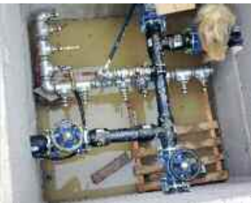
I lavori per l'ammodernamento e il risanamento dell'acquedotto di Lusérn
